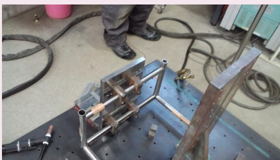
Fig 8 フレーム溶接
