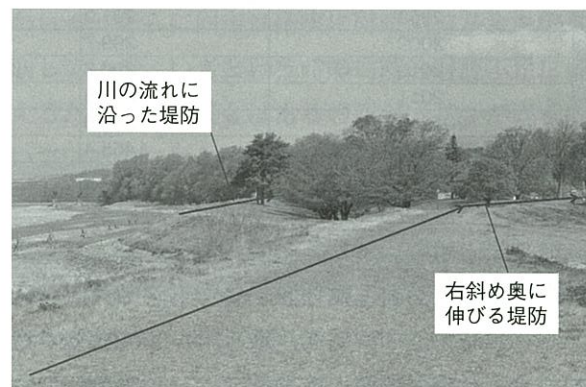
写真1 山梨県甲斐市に残る信玄堤（竜王堤）
