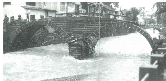
写真 中島川にかかる眼鏡橋の被災（長崎県土木部提供）
