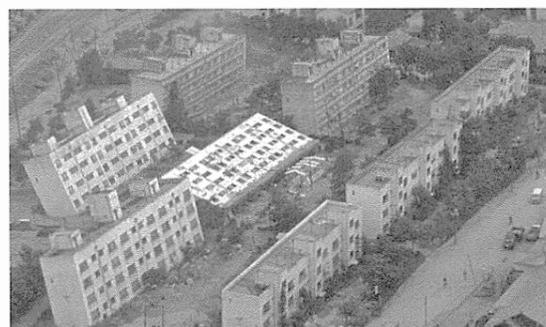
液状化による県営川岸町アパートの転倒、傾斜
