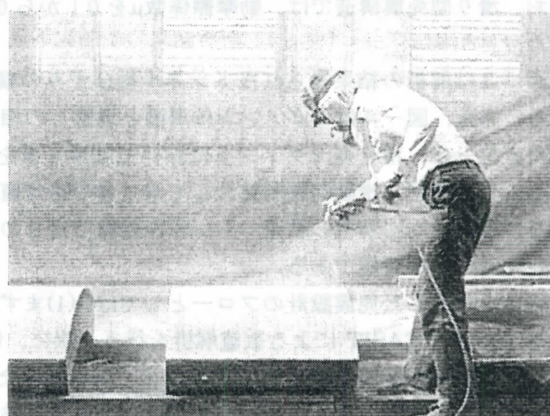
写真-1 滑動塗料の塗布状況
