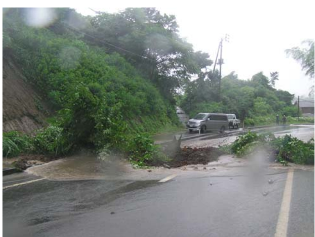
写真-4 豪雨による土砂崩れ
