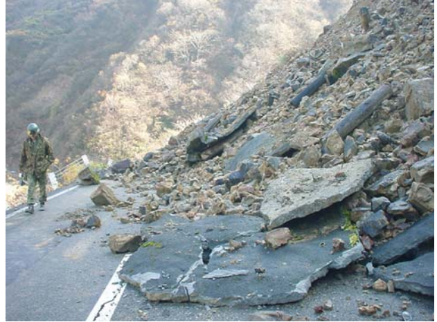
写真-2 がけ崩れによる道路閉塞
