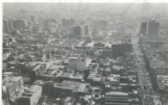
写真11 ラテンアメリカ塔 (41階, 181m) から市内展望 (倒壊したビルが点在している)
