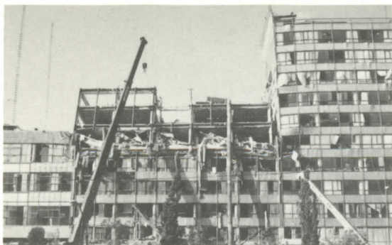
写真15 衝突によって倒壊したHotel de Carlo
