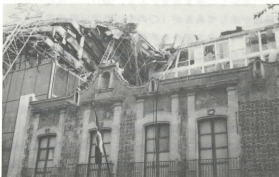
写真14 パンケーキ状崩壊の例
