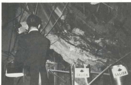
写真13 Pino Suarez駅改札口 (14階建ビルの梁, 床板)
