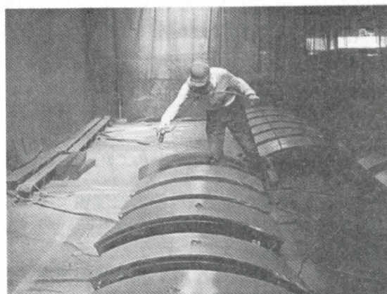
Photo.3 セグメント外周面への滑動塗料塗布状況
