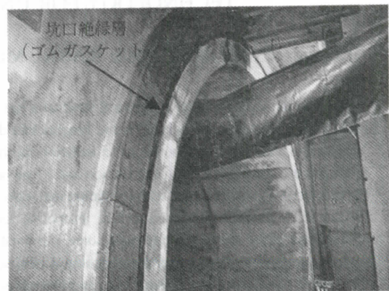
Photo.7 坑口の仕上り状況
