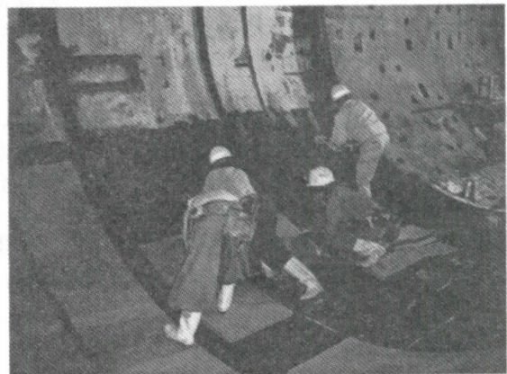
Photo.6 絶縁層（ゴムパネル）の貼付け状況
