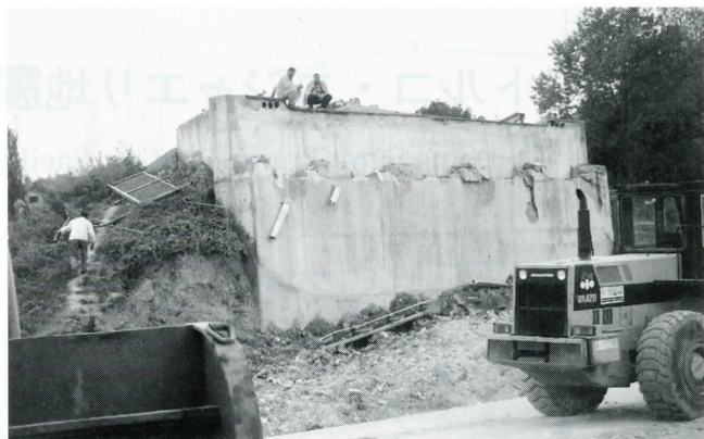
写真-2 Arifiye 橋 A 2 橋台
