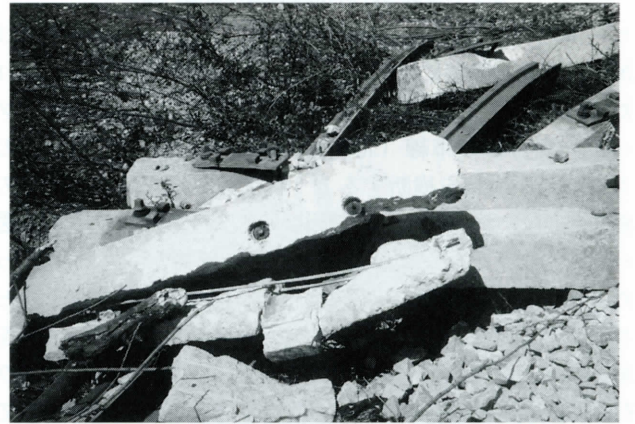
写真-19 撤去された枕木
