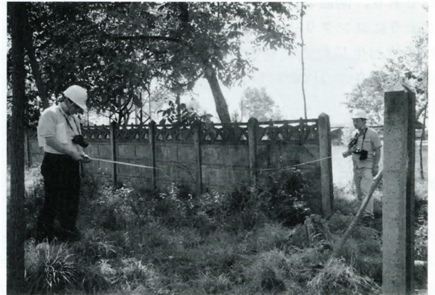
写真-11 地震断層によって水平移動したフェンス
