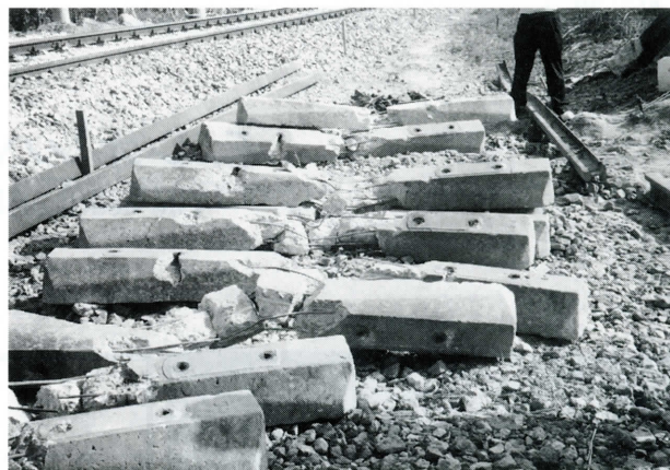
写真-21 撤去されたレールと枕木
