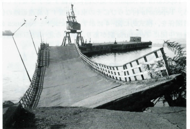
写真-16 SEKA 製紙工場栈橋への連絡橋
