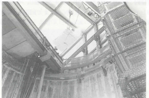
写真-9 セグメントの立坑への搬入
