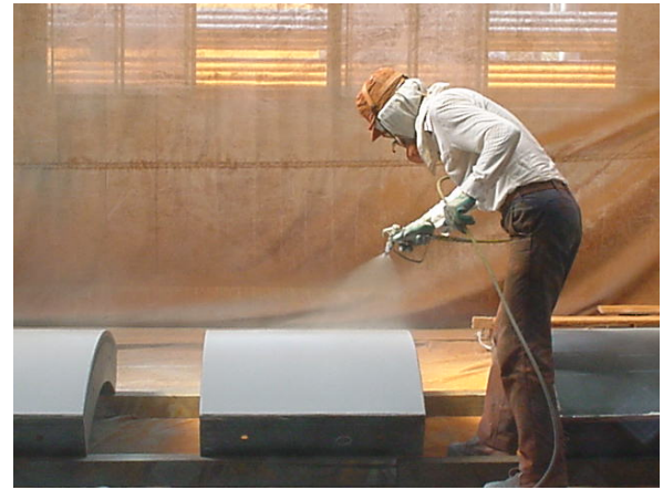
写真-2 スプレーによる滑動塗料の塗布状況
