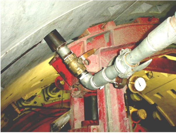
写真-1 免震材の注入状況
