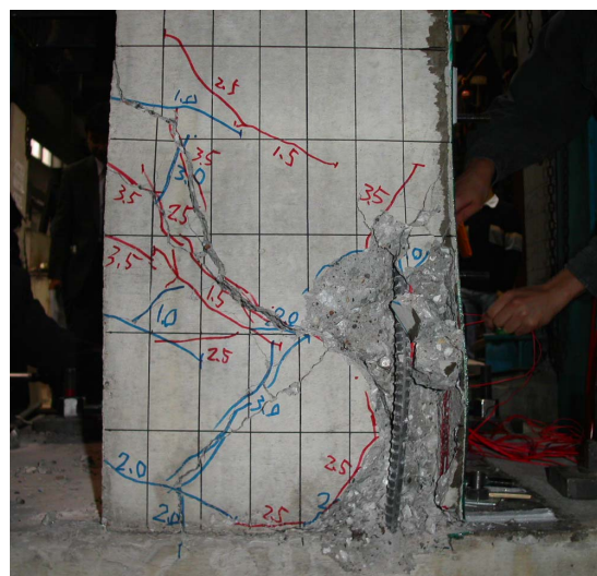
写真-9 CFRP シート 4 層 + 拡張式アンカーで耐震補強した場合の損傷状況（ドリフト 4.5%終了時、S 面）
