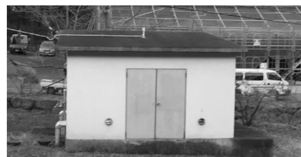
写真3 入田観測点の雨量センサー（屋根の上）
