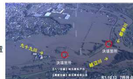
入間川流域における浸水被害状況
